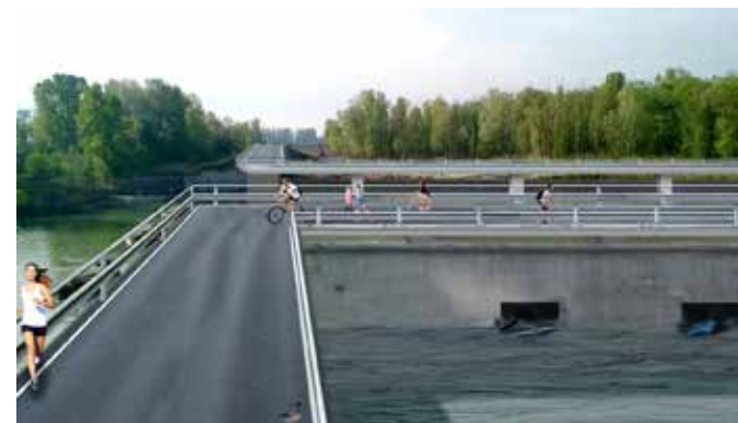
Diga o manufatto di sbarramento: a sinistra l'attuale aspetto della diga, a destra un render che mostra il ponte ciclo-pedonale che sarà costruito sopra al manufatto e permetterà l'attraversamento del fiume
