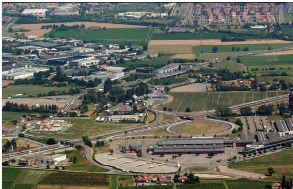
A sinistra, visione aerea dell'area del Casello autostradale Modena Nord; sotto, un esemplare di nutria
