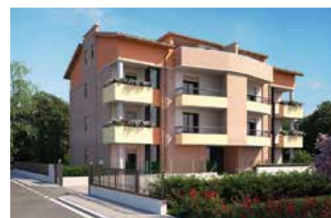
MODENA SALVO D'ACQUISTO EST "VIA RICCIONE civ. 20" Palazzina signorile di sole 6 unità abitative ad ELEVATA EFFICIENZA CLASSE ENERGETICA "A"
