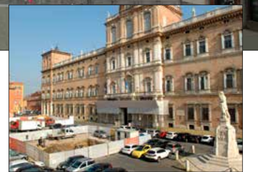
Immagine di piazza Roma come diventerà dopo la pedonalizzazione e foto dei cantieri in corso. Sotto, il logo della "app" sul centro storico
