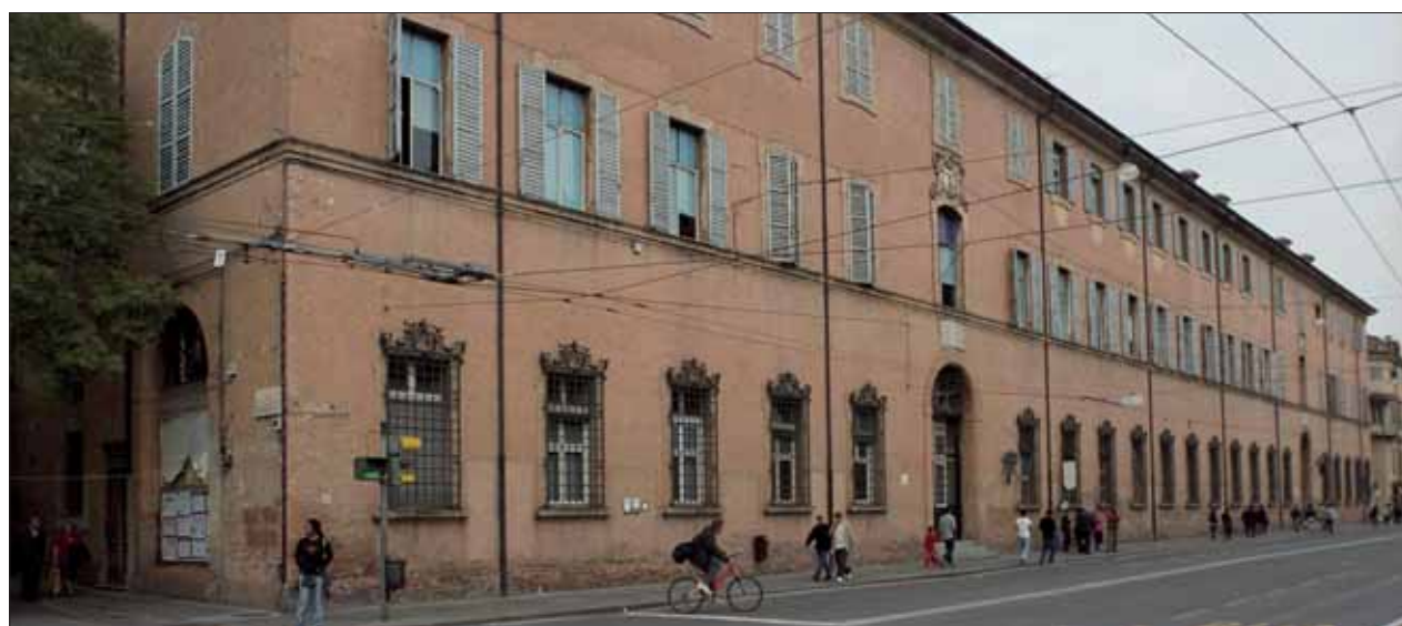
La facciata dell'ex ospedale sant'Agostino
