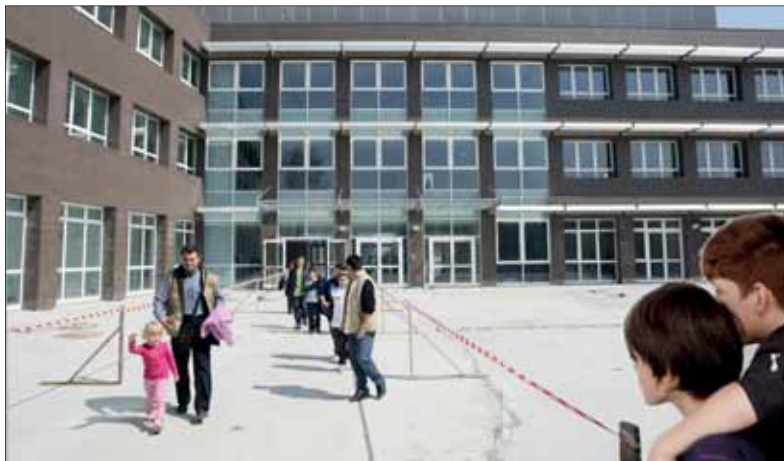
Il cantiere della nuova scuola Marconi
