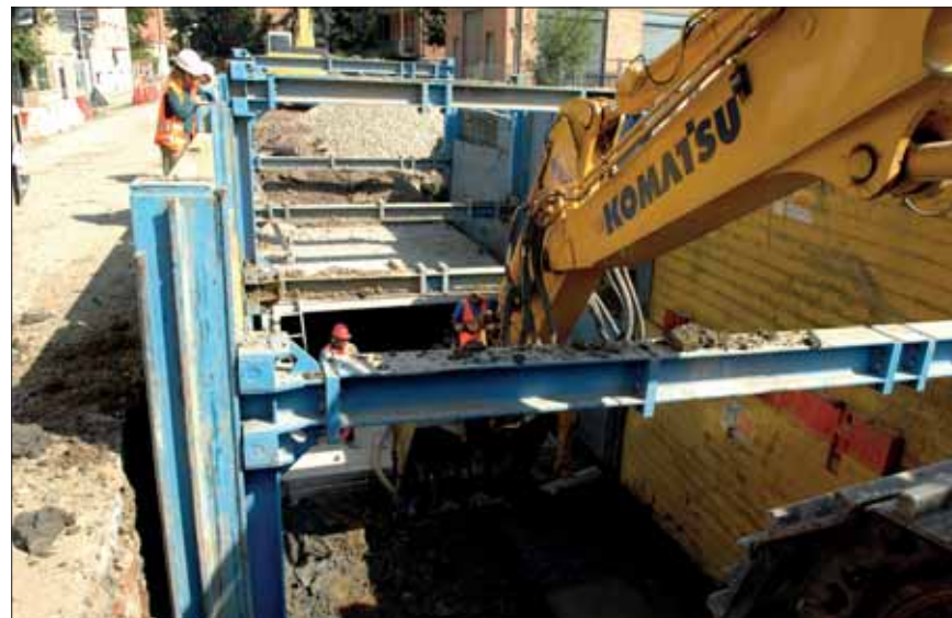
Lavori in corso per la realizzazione del collettore di levante
