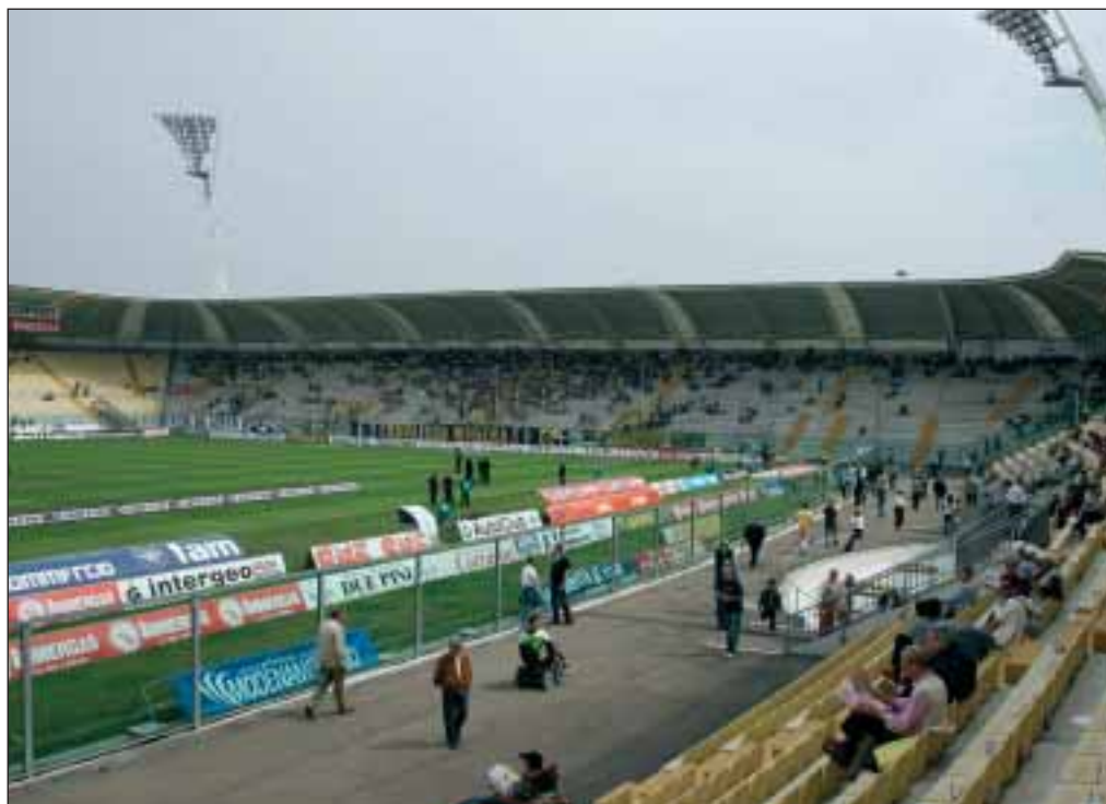
La copertura della curva sud dello stadio comunale Alberto Braglia
