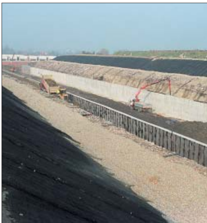
La trincea per il passaggio della linea dell'alta velocità. Sotto: il sindaco di Modena Giorgio Pighi
