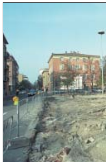
Il cantiere in via Trento Trieste
