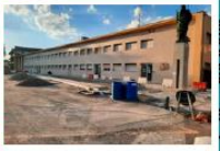
Cantiere fronte Palazzina Pucci
