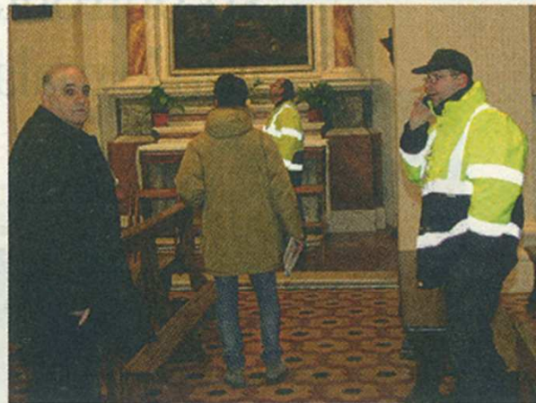
Il sopralluogo in una chiesa di montagna dopo una scossa sismica
