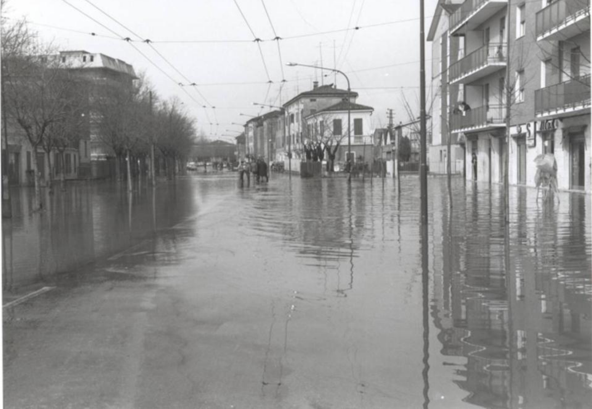
1972: Allagamento a Modena di Via Cesare Costa (foto M. Stradi in Lombroso e Quattrocchi (2008))
