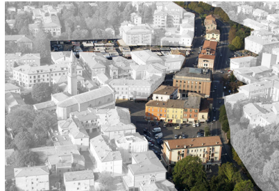
Cavezzo (MO) zone interessate da crolli
