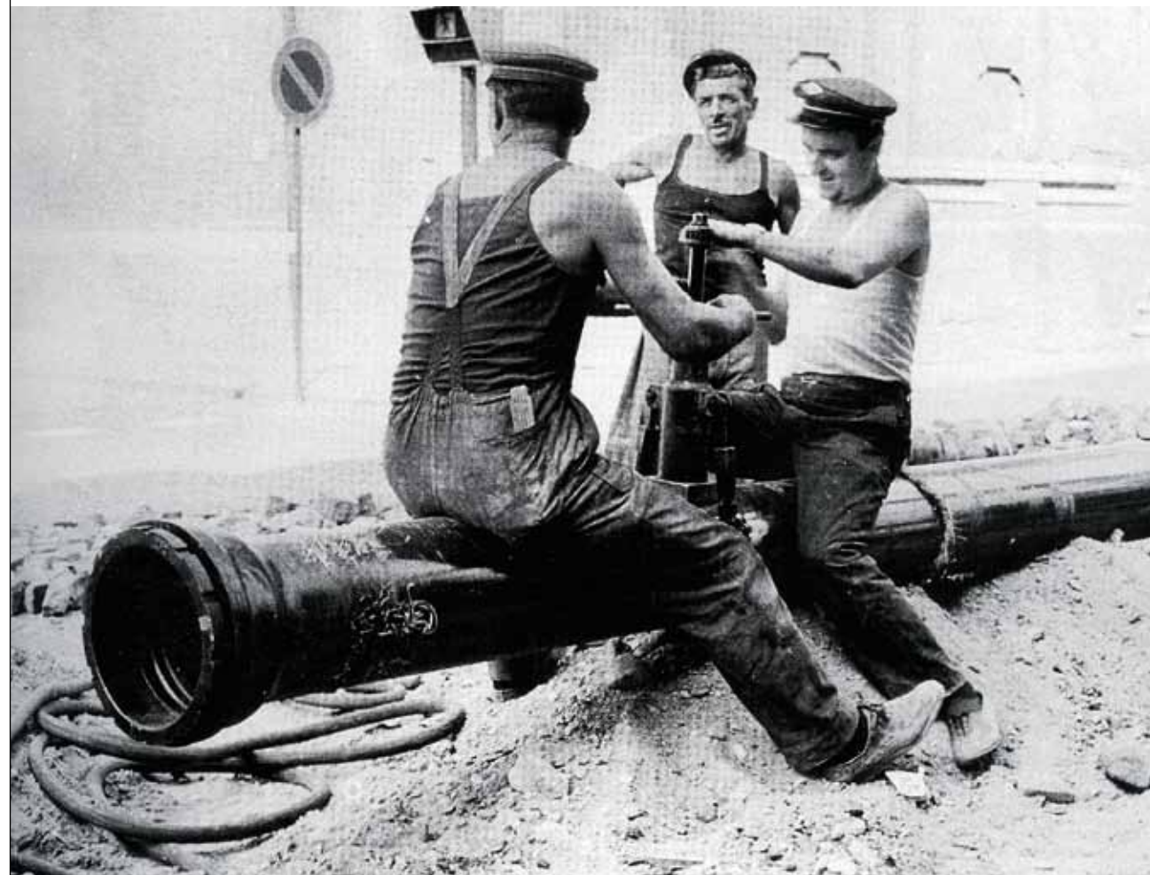
Lavori di rinnovo della rete del gas in Via Emilia Centro, per adeguarla al metano (1962, Archivio AMCM-Hera S.p.A.)
