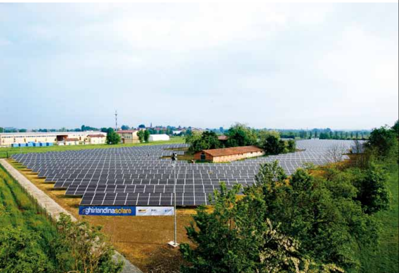
Parco fotovoltaico di Marzaglia realizzato da Ghirlandina Solare, società di progetto composta da Cpl Concordia, Ing. Ferrari spa e Hera Energie Rinnovabili (2011, Foto Rosa - Archivio Hera S.p.A.)
