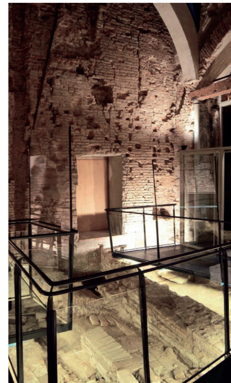
L'ingresso del Palazzo Comunale prima degli ultimi interventi.
