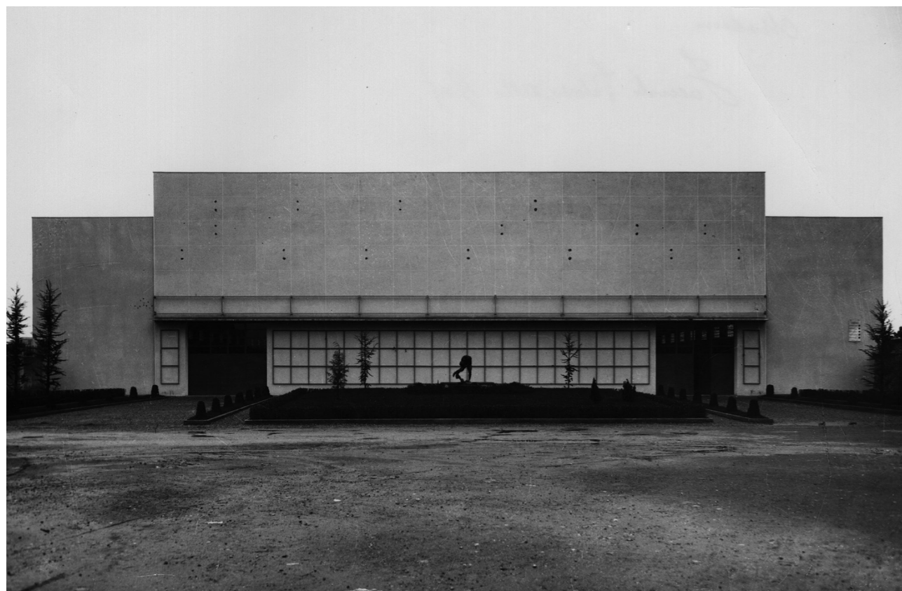
Il vecchio Palazzo dello Sport appena costruito.
