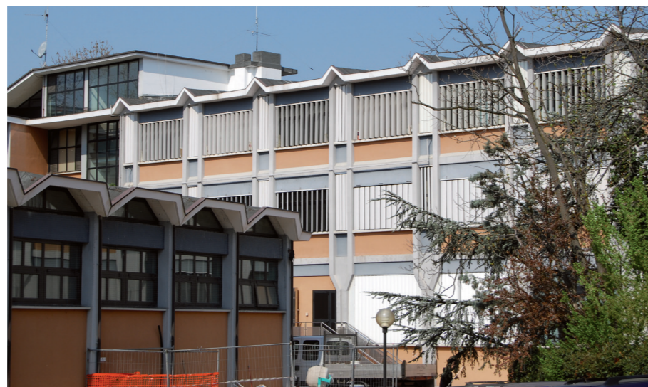
Vista del retro dell'Istituto.
