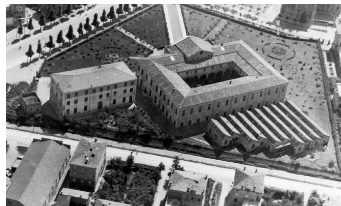
Vista aerea degli anni Trenta-Quaranta prima della realizzazione dell'attuale sede.
