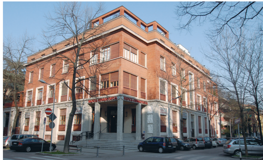
L'edificio da viale Reiter.
