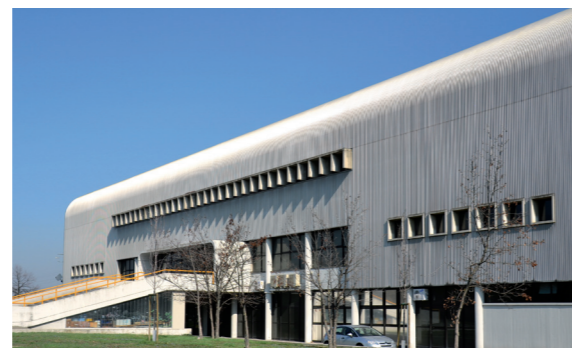
Vista del fronte laterale su via Divisione Acqui.
