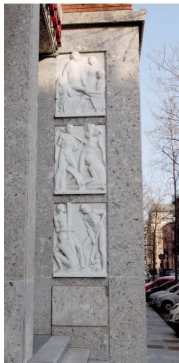
Dettaglio del portico di ingresso.
