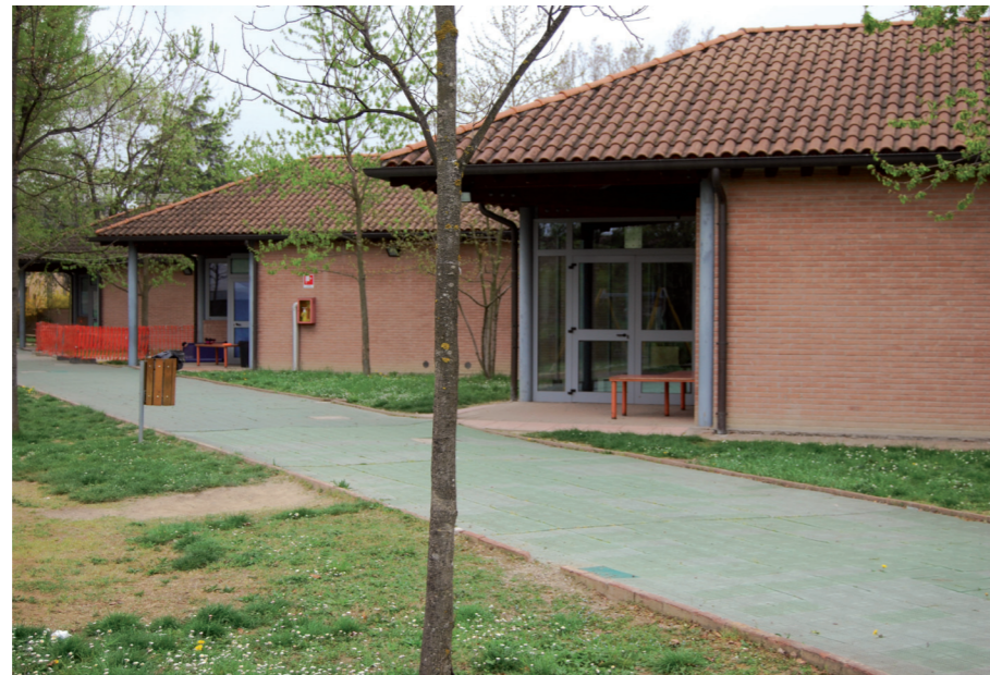
I moduli delle aule visti dal cortile.
