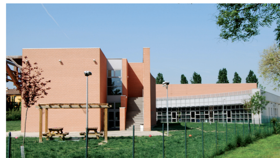
Il fronte d'ingresso alle aule e del refettorio.
