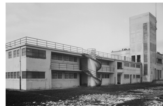
La piscina appena ultimata.
