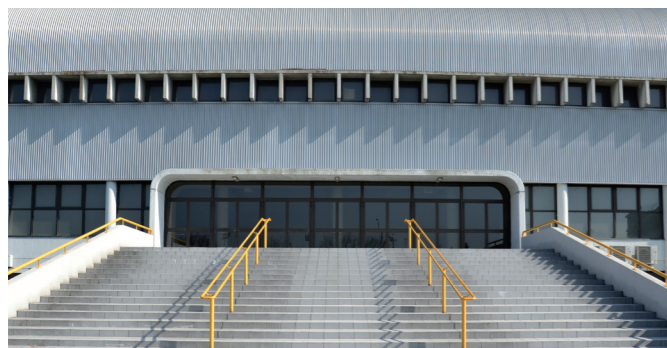
Dettaglio di una delle scale esterne di accesso.
