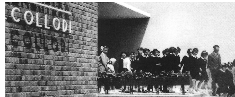
L'edificio all'epoca dell'inaugurazione.
