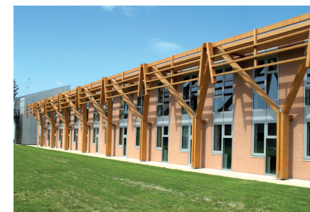
Vista del fronte sud del corpo delle aule.
