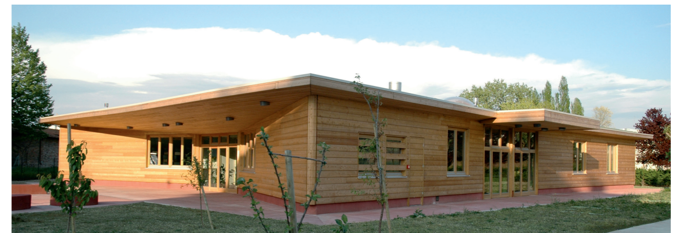
Vista esterna dell'edificio.
