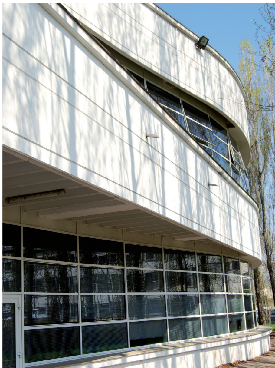
Dettaglio della biblioteca scientifica interdipartimentale.
