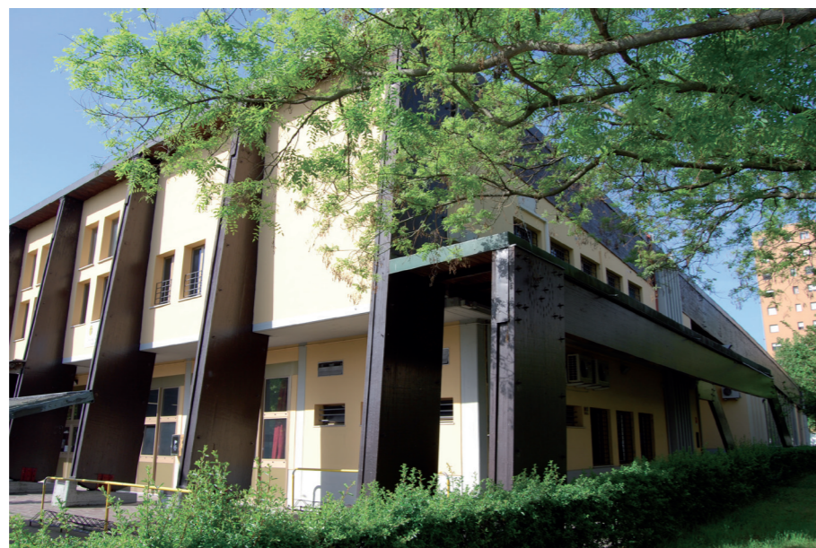
L'edificio con le strutture portanti in vista.
