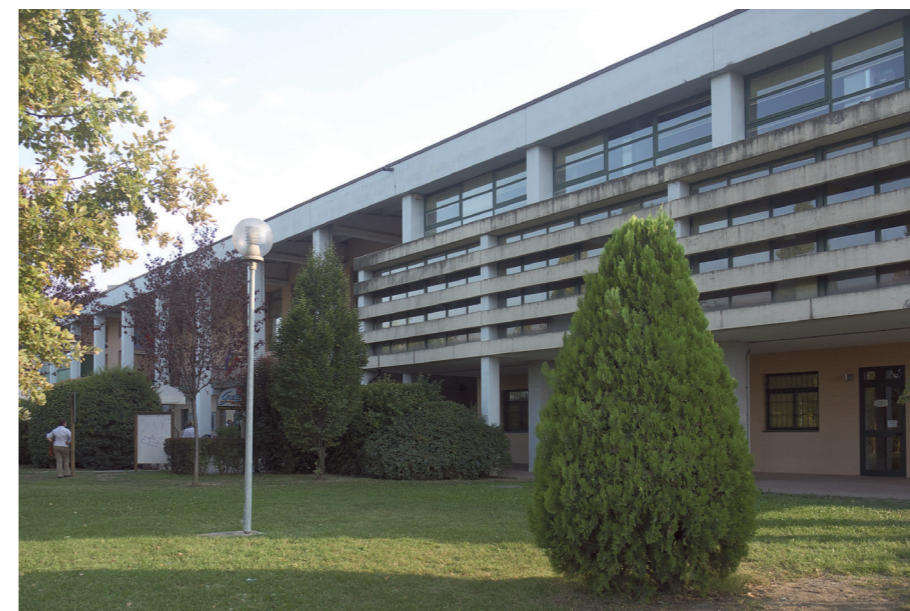
Vista del fronte principale.
