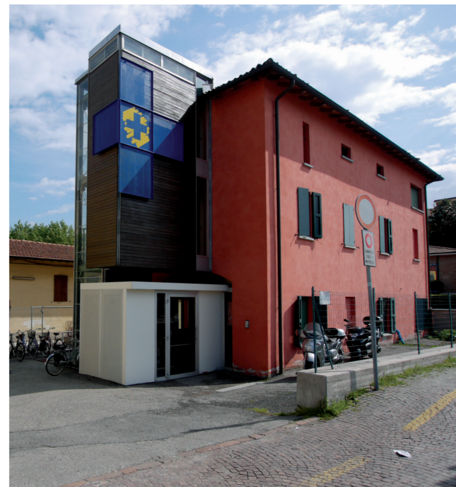
Vista complessiva dei due volumi.
