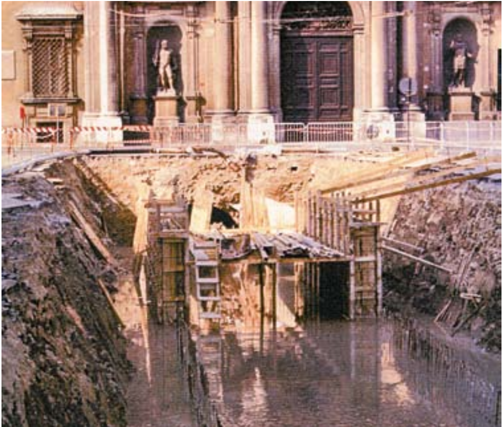
Lavori di rifacimento del Canal Chiaro in Piazza Roma, 1984. (da La città che non si vede. Modena e l'acqua: sistema idraulico e fognario , a cura di G. Bartoli, Comune di Modena, 2003)
