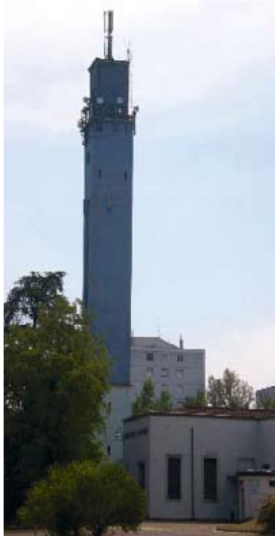
Torre piezometrica dell'acquedotto di Modena. (Archivio Hera Modena)
