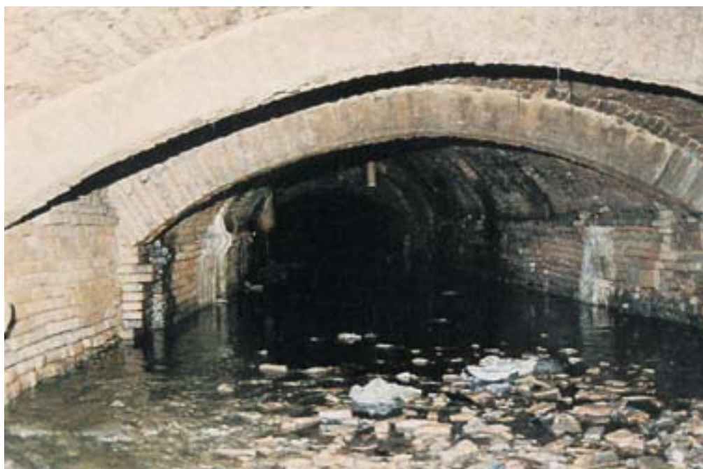
Figura 18 - Uno dei grandi canali nel centro storico, coperti dal XVII secolo. (da La città che non si vede. Modena e l'acqua: sistema idraulico e fognario ”, a cura di Giovanni Bartoli, Comune di Modena, 2003)
