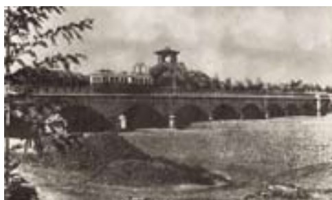
Figura 12 - Il ponte di Spilamberto sul F. Panaro ad inizio secolo ed oggi (sullo sfondo Villa Rangoni). Si notino nella prima figura le prime modeste estrazioni di ghiaia, che, in modo ben più consistente, sarebbero avvenute nel secondo dopoguerra, innescando i fenomeni erosivi. Ad inizio secolo le pile del ponte risultano quasi totalmente sommerse dalla ghiaia, mentre oggi sono del tutto scoperte e solo la creazione della traversa ha impedito che esse fossero scalzate: si noti infatti il dislivello tra la base della traversa ed il culmine degli archi, misura dell'abbassamento totale dell'alveo. (da M. Pellegrini, Riflessi idrogeologici dell'attività estrattiva di materiali inerti in alveo ed extra-alveo nelle aree di conoide . Dagli Atti del Convegno – Attività estrattiva dei materiali inerti da costruzioni; effetti sugli ambienti e risorse alternative , 1978)
