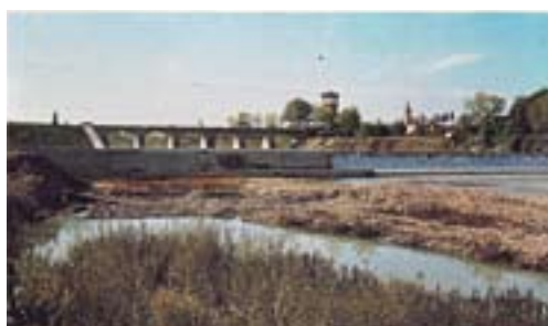
Figura 12 - Il ponte di Spilamberto sul F. Panaro ad inizio secolo ed oggi (sullo sfondo Villa Rangoni). Si notino nella prima figura le prime modeste estrazioni di ghiaia, che, in modo ben più consistente, sarebbero avvenute nel secondo dopoguerra, innescando i fenomeni erosivi. Ad inizio secolo le pile del ponte risultano quasi totalmente sommerse dalla ghiaia, mentre oggi sono del tutto scoperte e solo la creazione della traversa ha impedito che esse fossero scalzate: si noti infatti il dislivello tra la base della traversa ed il culmine degli archi, misura dell'abbassamento totale dell'alveo. (da M. Pellegrini, Riflessi idrogeologici dell'attività estrattiva di materiali inerti in alveo ed extra-alveo nelle aree di conoide . Dagli Atti del Convegno – Attività estrattiva dei materiali inerti da costruzioni; effetti sugli ambienti e risorse alternative , 1978)
