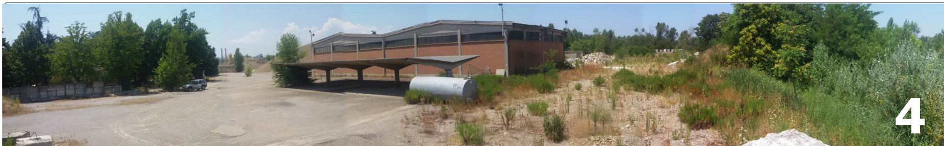
Vista da nord dell'angolo nord-est dell'area di intervento: sulla dx vegetazione spontanea a l confine nord; al centro gli edifici in elevazione che saranno demoliti preliminarmente al presente progetto; sulla sx l'area di accesso alla cava Rangoni; sullo sfondo l'impianto del conglomerato bituminoso al confine sud.
