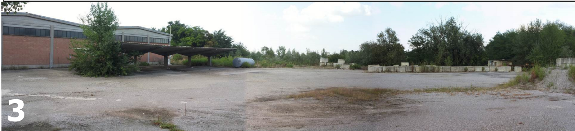
Vista dell'angolo nord-est della cava "Rangoni". Sulla dx sono visibili manufatti in c.a. che verranno ricollocati e posizionati a protezione dei ricettori sensibili; sulla sx opere in elevazione che saranno demolite con iter indipendente preliminare all'attivazione del presente progetto.
